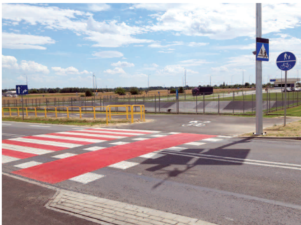
Budowa sieci dróg dla rowerów oraz parkingów Parkuj i Jedź (P&R) na terenie gmin Oborniki Śląskie, Wisznia Mała, Oleśnica i miasta Oleśnica
