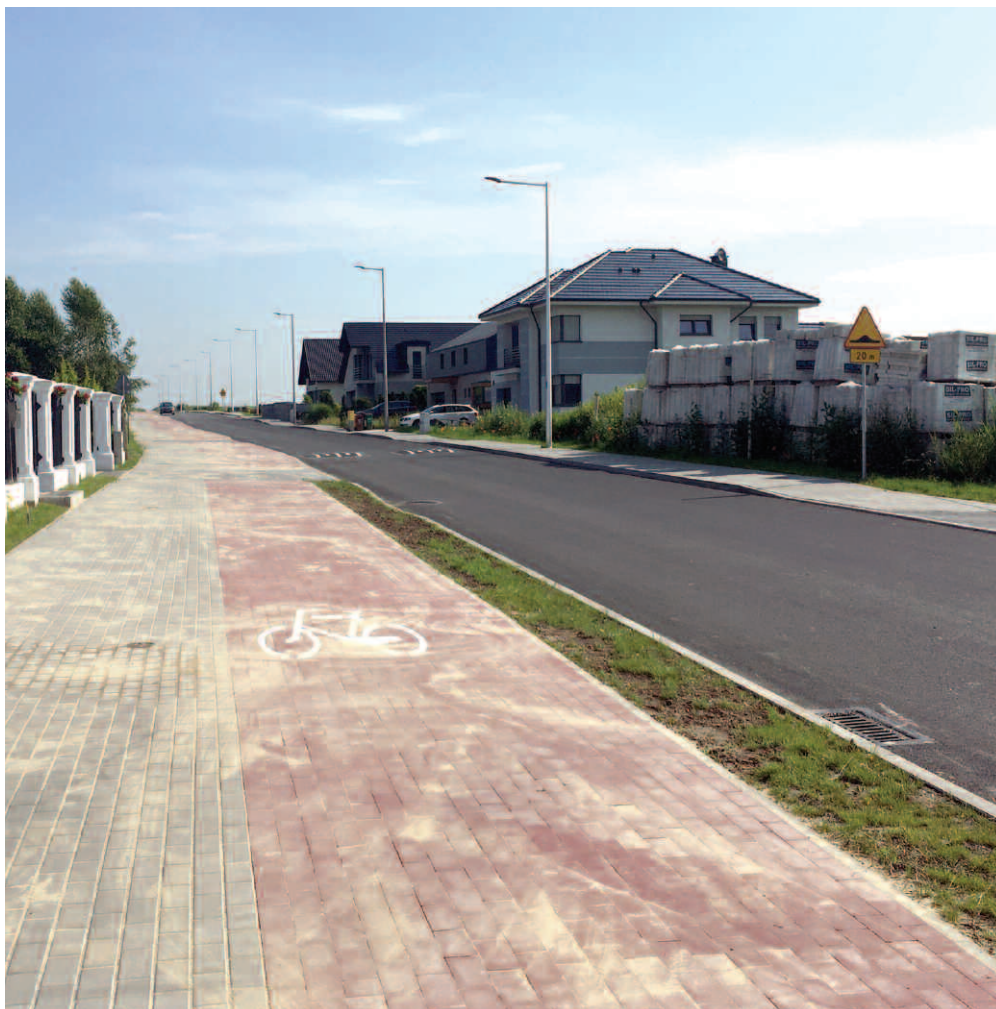
Budowa kanalizacji deszczowej na terenie Gminy Miasta Oleśnicy
