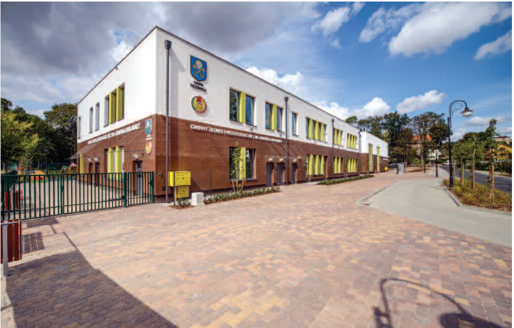
Budowa przedszkola wraz ze żłobkiem w Trzebnicy
