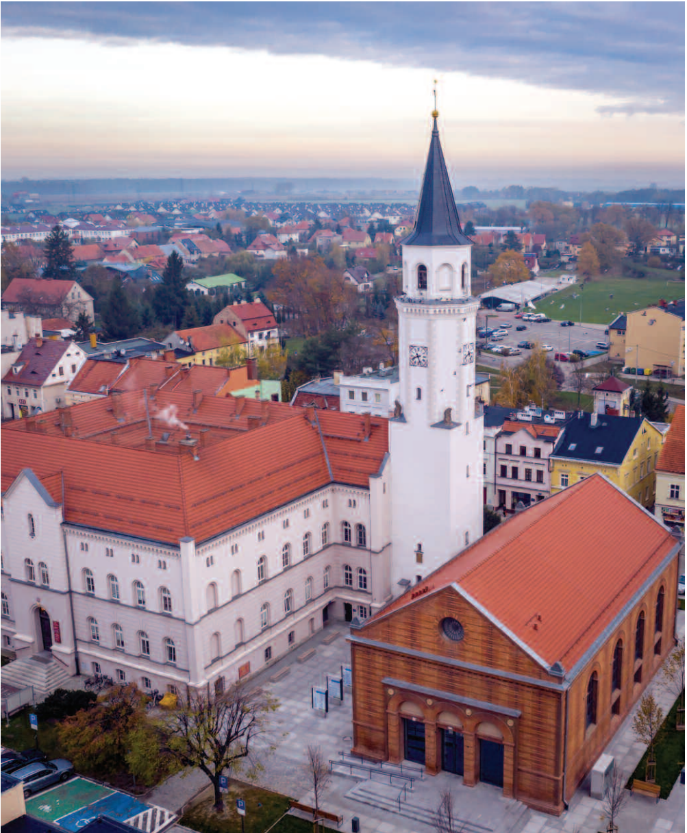
Rewitalizacja Rynku wraz z remontem dawnego kościoła ewangelickiego w Kątach Wrocławskich
