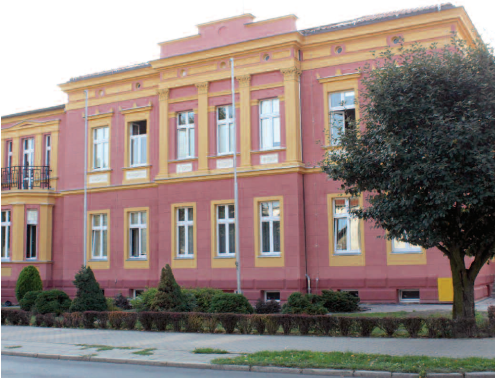
Termomodernizacja Urzędu Gminy Oleśnica
