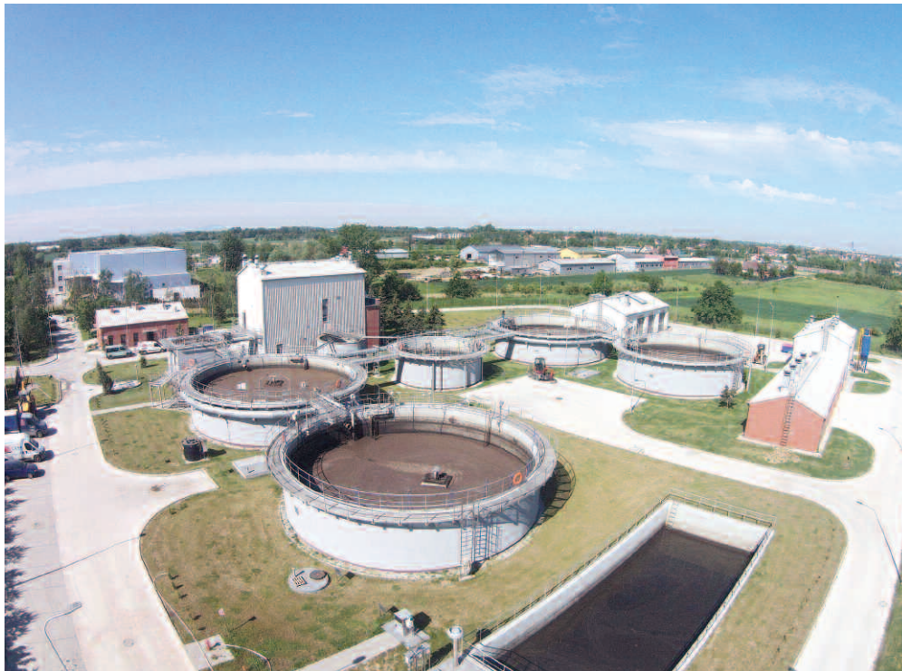
Modernizacja oczyszczalni ścieków w Siechnicach
