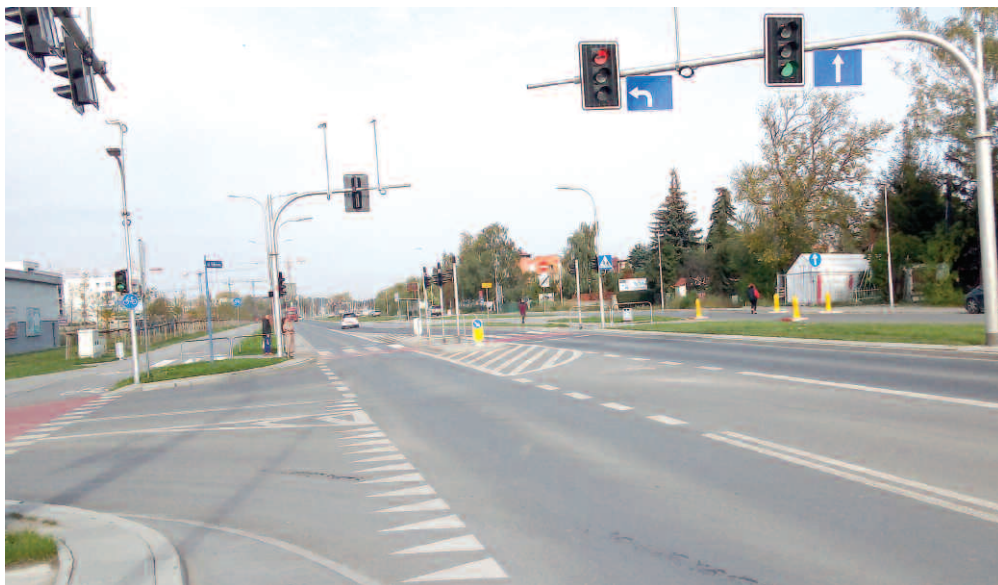
Przebudowa ul. Buforowej we Wrocławiu
